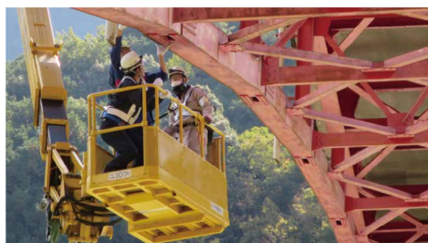
写真 猿飼橋の診断状況
