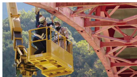
写真 猿飼橋の診断状況
