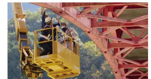
写真 猿飼橋の診断状況
