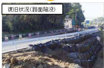
写真 応急復旧への技術指導 (道路局記者発表資料より)
