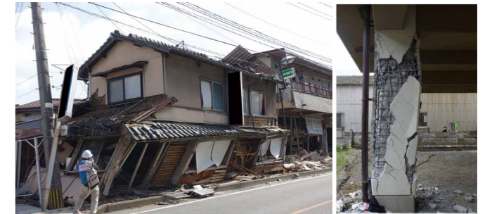
写真 建築物の被害状況 (左: 木造 / 右: RC 造)
