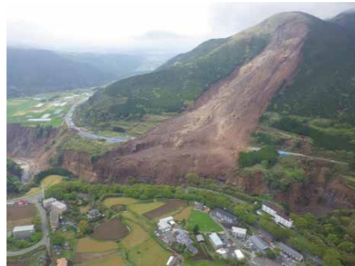
写真2 阿蘇大橋付近の大規模な斜面崩壊
