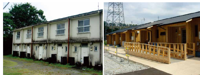
写真1 既存公営住宅団地内の老朽化した住棟を除却して災害公営住宅を整備するニーズがあります。
