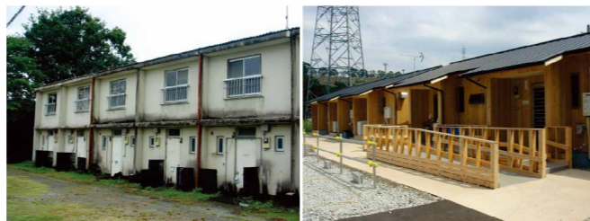
写真1 既存公営住宅団地内の老朽化した住棟を撤去して災害公営住宅を整備するニーズがあります。 写真2 木造の応急仮設住宅を再利用して災害公営住宅等を整備するニーズがあります。
