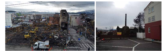
写真1 焼損区域中央部の被害 写真2 軽微な被害の建物
