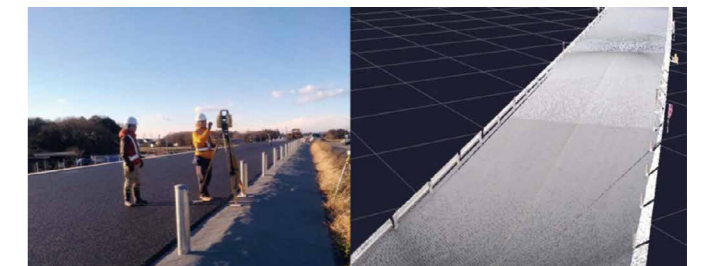
図 レーザースキャナーによる出来形計測(左)と取得点群データ(右)
