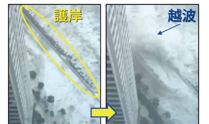
写真 マリンシティでの越波の状況(提供:韓国海洋大学校 金度三 教授)
