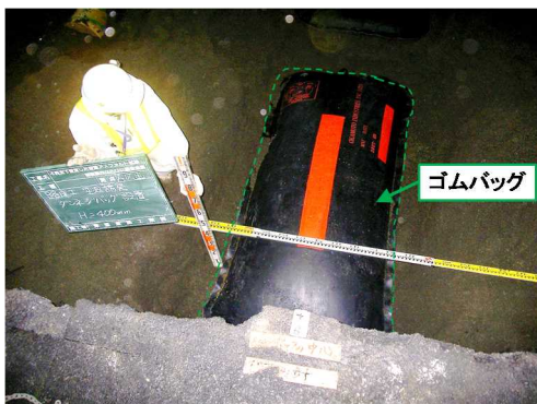
写真-6.1 ゴムバッグ厚さ40cmの設置状況
