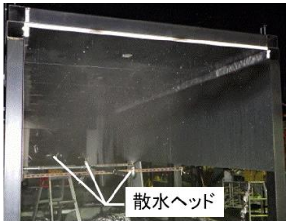
図 2.3.81 散水時の状況
