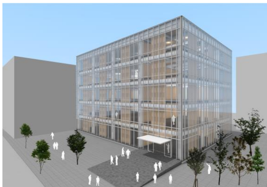
図 2.1.13 タイプⅡ(事務所)の外観
