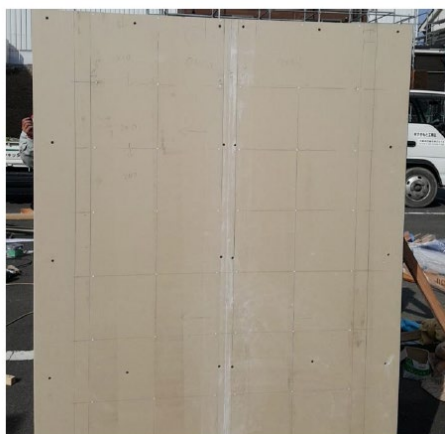
写真2.2.7 透湿防水シートの水濡れ感知シール（全体）
