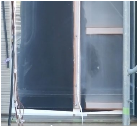
縦胴縁 横胴縁 スモーク実験による通気の状態
