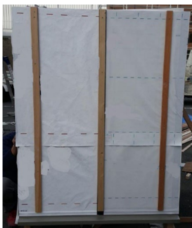
写真2.2.5 透湿防水シートの水濡れ感知シール（全体）
