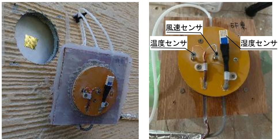
(c) 通気層内センサの設置状況 (東面5F、風速計、温湿度計、差圧計用チューブ)
