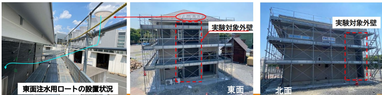
写真 2.4.1 実験住宅の外観および注水状況
