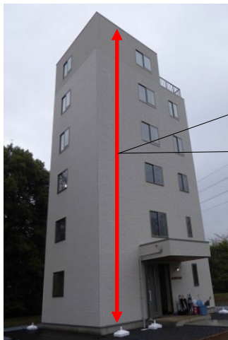
図4.2.12 中層建築物による通気層と中間階の給排気口
