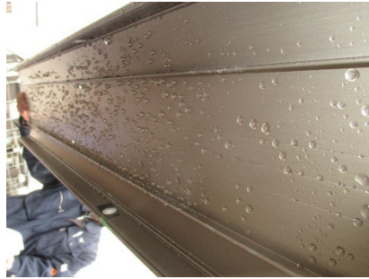
写真 2. 2. 10 笠木裏面の付着水
