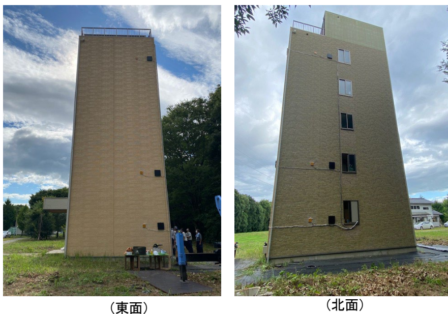
写真2.5.4 センサの設置後の建物の外観
