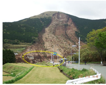
(a) 大規模な斜面崩壊状況と阿蘇大橋架橋位置
