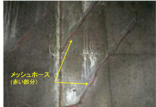
写真-5.8 桁内部のひび割れ補修状況
