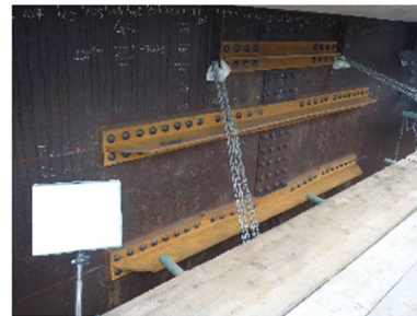
(b) ウェブに設置した水平補剛材
