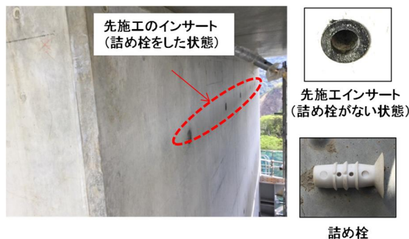
写真-6.6 橋脚に設置した先施工のインサート
