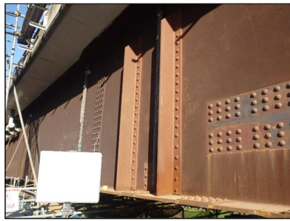
写真-3.5 主桁支点部への補剛材追加 (G5 主桁 P3 橋脚上の支点部)
