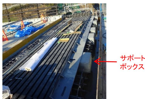
写真-6.4 断層交差部のモジュラージョイント(施工中)
