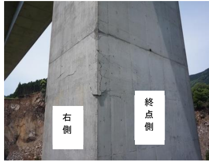
写真-5.4 P3橋脚の断面外面と内面の損傷状況
