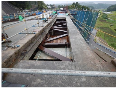
床版の一部撤去
