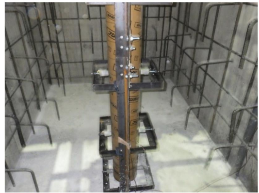
写真-5.6 P3 橋脚内空側の配筋状況
