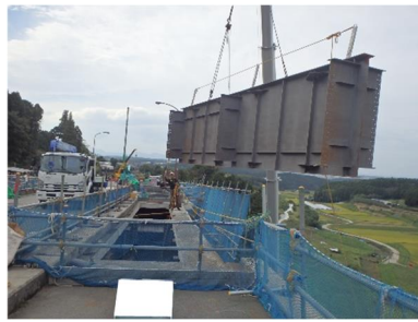
追加桁落とし込み
