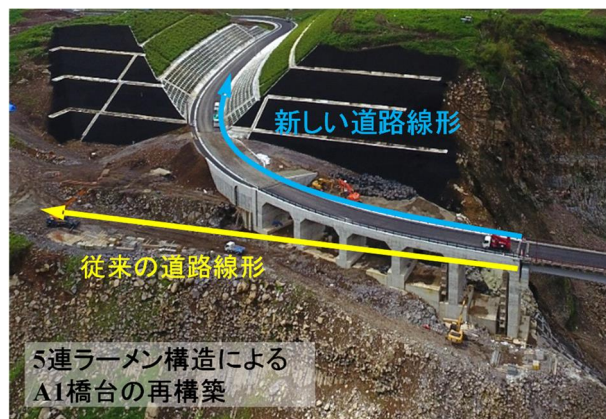
写真-5.7 A1 橋台部の復旧の全景
