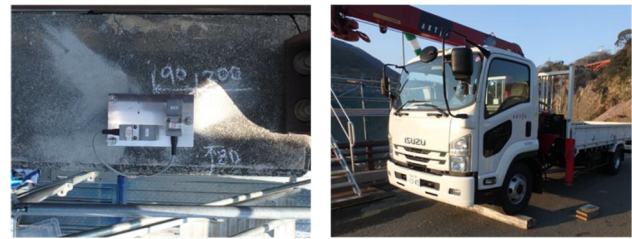
写真-5.10 加速度計設置状況及び加振状況
