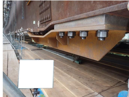
(a) 下フランジに設置したあて板
