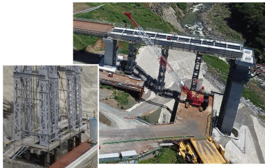
写真-6.8 断層交差部に仮設されたベント基礎 (施工中)
