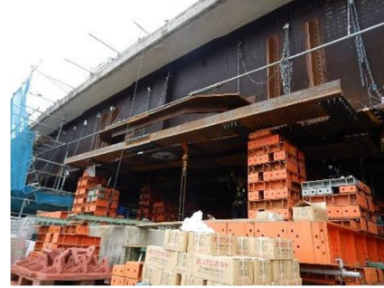
写真-3.6 主桁中間支点部へのパイパス材の設置
