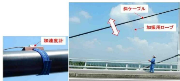
写真-4.3 斜ケーブルへの加速度計の設置状況
