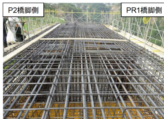
写真-6.7 あきを広めに設定した P3 橋脚橋座部の配筋
