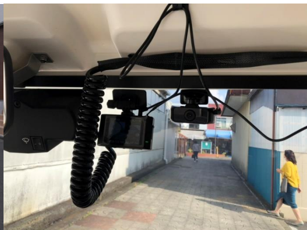
図 3.2.9 ドライブレコーダーの設置
