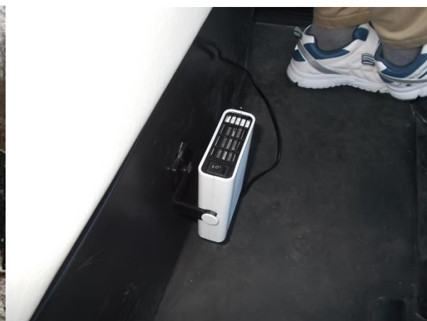
図 3.2.11 車内ヒーターの設置 (C 団地)
