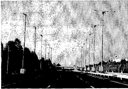
照明実験施設外観
