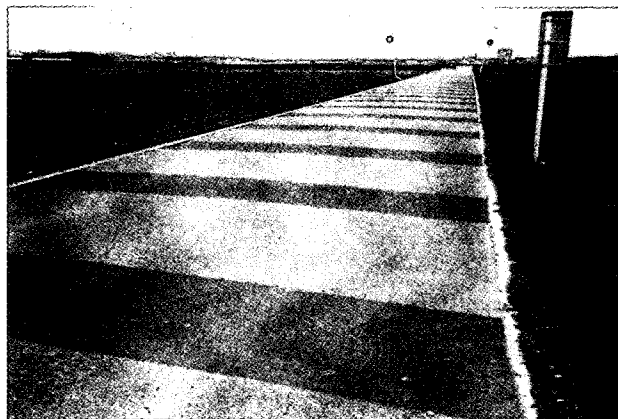
写真-1 段差舗装の施工例
