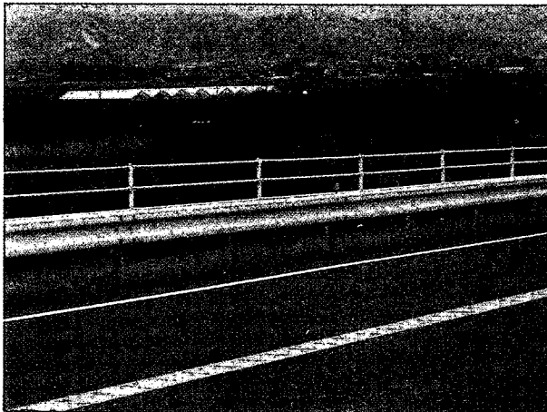
車道側から見た構造
