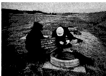
地上型感震器の点検
