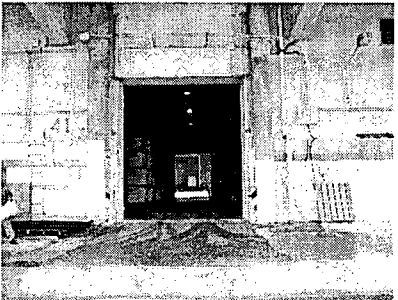
全景(倉庫入り口)
