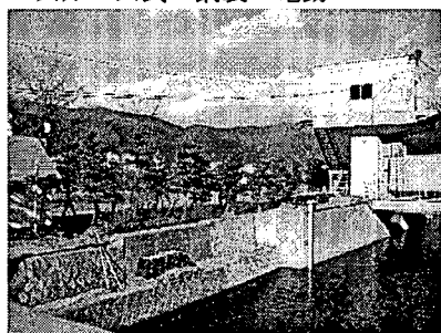
右岸側-内水位計
