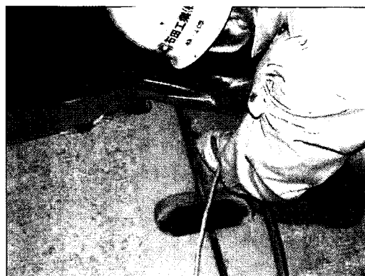
写真-22 目地用グラウト材注入状況
