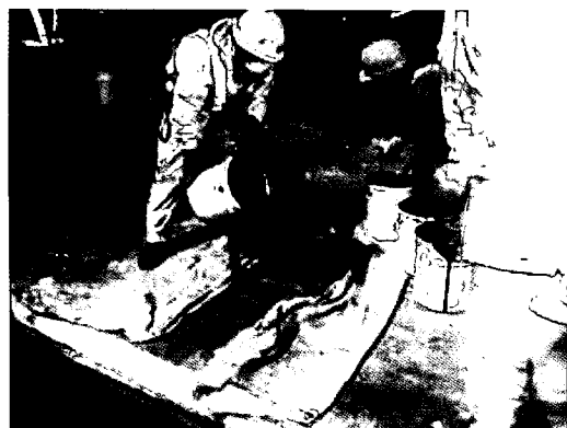
写真-8 裏込めグラウト材注入状況
