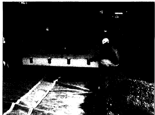
写真-16 枕版敷設状況
