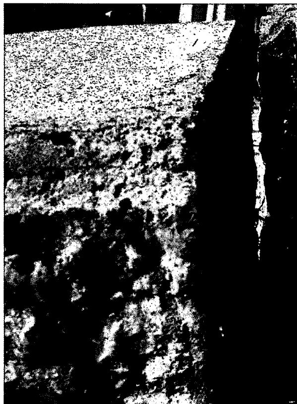
写真G 6.2 岩手県 日向ダムの高欄部継目の開き状況 天端にて最大 1,111gal の加速度が観測されたが、堤体本体の変状はなかった
