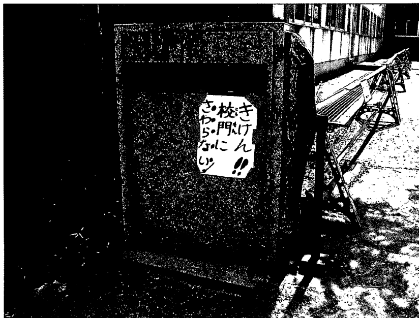
写真G 9.2 気仙沼市立階上（はしがみ）小学校校門の被害
