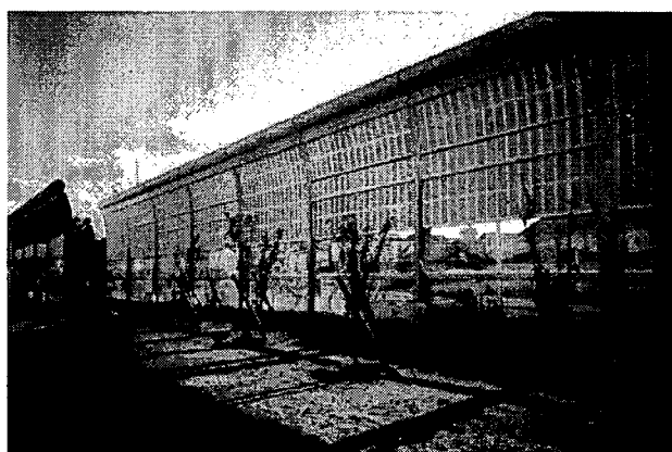
図-1 光触媒の遮音壁への適用例(名古屋市守山区)
