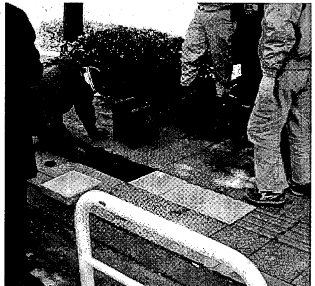
写真-1 RF-IDタグ内蔵点字ブロックの設置状況
