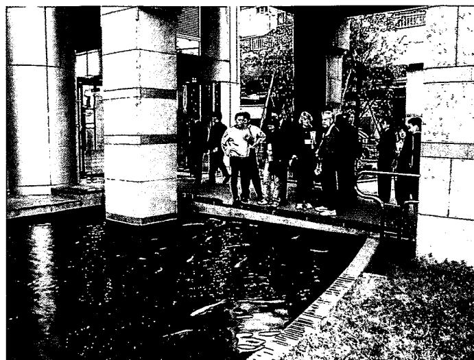
写真一 5 再生水による修景施設 (有明処理場)
