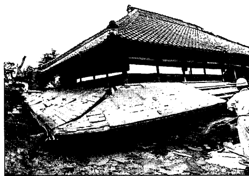
写真 9.2 被害例 1 ・南西側
