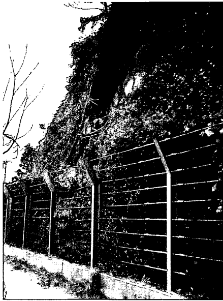
写真 8.5 斜面右下部の剥落 剥落した岩塊は、全て落石防護柵内に収まった。
