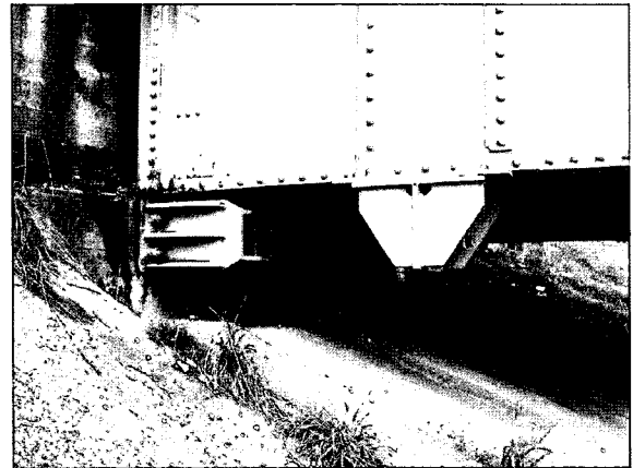
写真 7.4 小野橋の落橋防止構造（張力が作用した状態で落橋防止が有効に機能したと推定）
