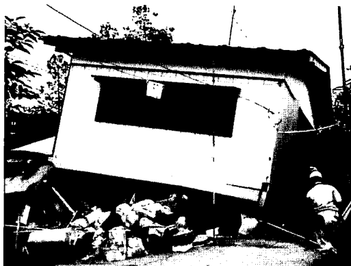
写真 9.5 被害例 3 ・ 1 階の層崩壊
