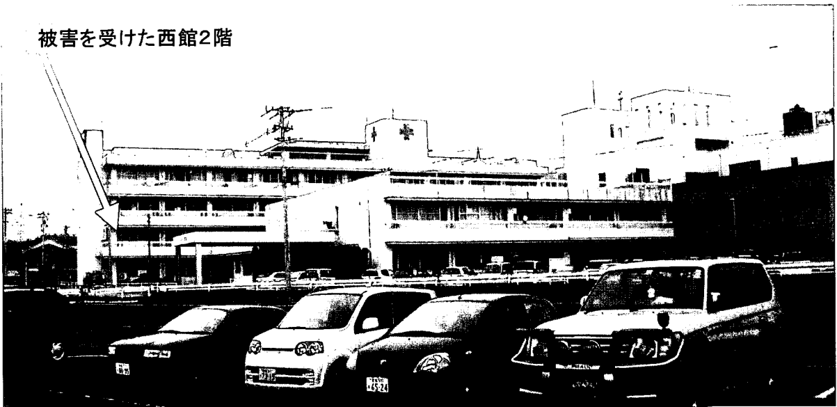
写真 9.34 建物全景（深谷病院）
