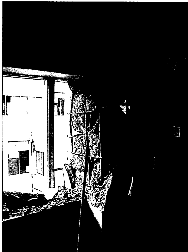
写真G 9.3 鉄筋コンクリート造建築物の被害(鹿島台町)
