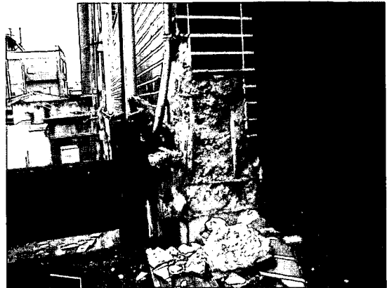
写真 9.33 2階入口付近の柱脚の被害 （鹿島台町役場）
