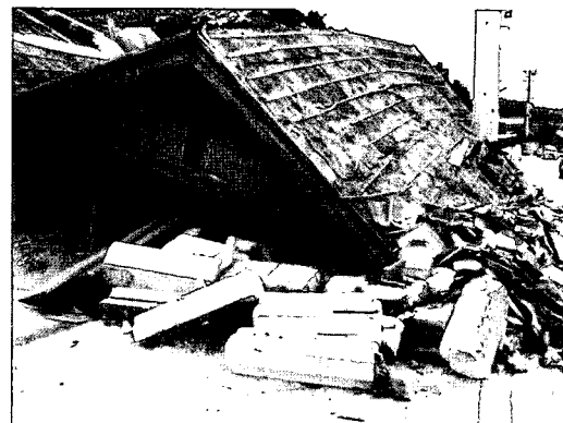
写真 9.14 被害例 8 ・石積が崩壊
