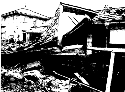
写真 9.13 被害例 7 ・右端に石積が残る
