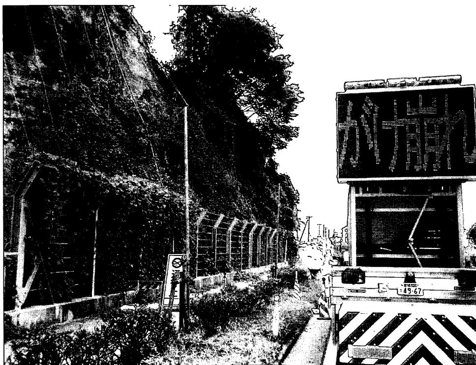
写真8.4 国道45号線40.6Kpの崖崩れ
