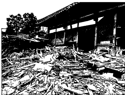
写真 9.1 被害例 1 ・小屋裏 2 階部分
