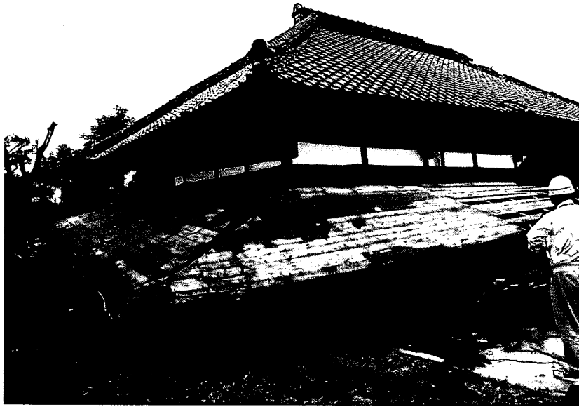
写真G 9.2 伝統的構法による木造住宅の被害(南郷町上二郷)
