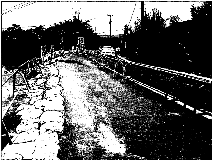
写真G 7.2 一般国道108号路肩の陥没（河南町前谷地）
