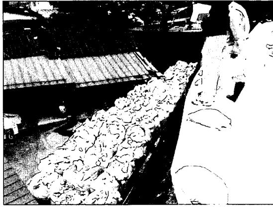
写真 7.14 擁壁下方の民家と土嚢積応急対策
