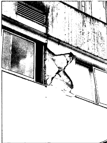
写真9.29 非構造部材の被害 （鹿島台病院・南棟）
