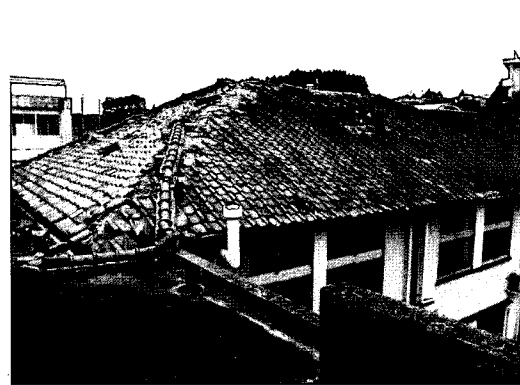
写真 9.18 木造棟・屋根瓦の落下状況
