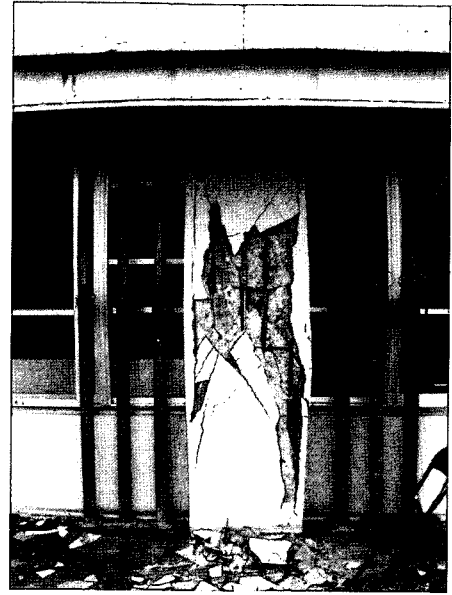
写真 9.36 2階柱のせん断破壊 (深谷病院)
