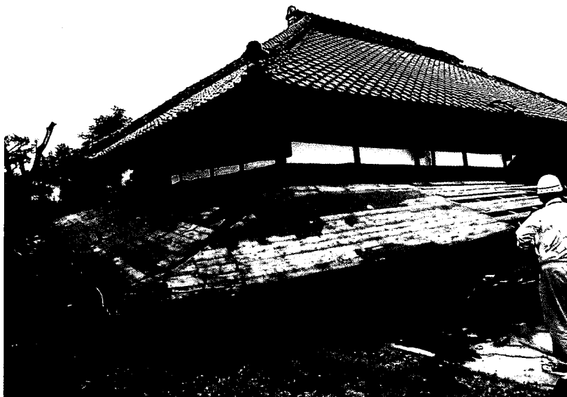
写真G 9.2 伝統的構法による木造住宅の被害(南郷町上二郷)
