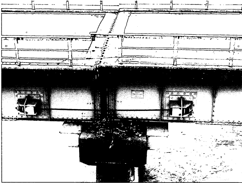
写真G 7.1 県道河南鳴瀬線小野橋（支承の破壊および桁の移動、宮城県鳴瀬町）
