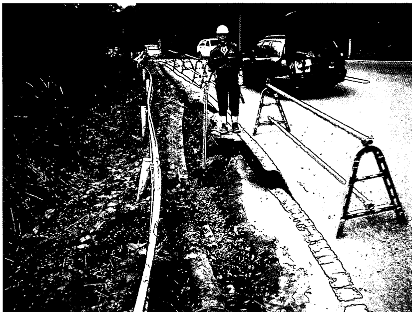
写真G 3.2 旭山撓曲上での道路陥没（県道河南町北村）斜面の傾斜方向への重力性移動が原因と考えられる。
