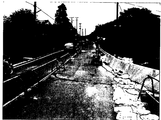
写真 7.13 路面上のクラック
