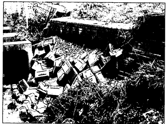
写真 7.11 横断水路ブロック積護岸の一部崩落
