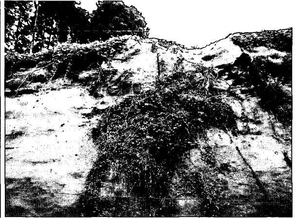
写真 8.8 斜面左上と中上の剥落部分
