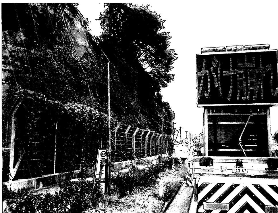
写真8.4 国道45号線40.6Kpの崖崩れ
