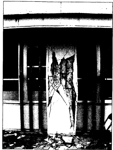
写真 9.36 2階柱のせん断破壊 (深谷病院)
