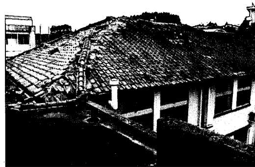
写真 9.18 木造棟・屋根瓦の落下状況
