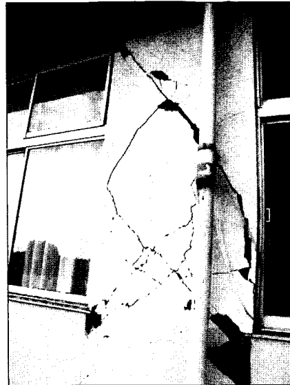
写真 9.39 柱のせん断破壊 (北村小学校)
