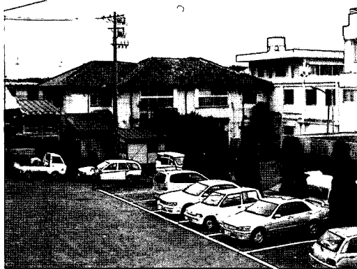
写真 9.17 木造棟・南からの外観
