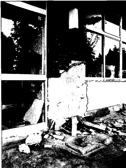
写真 9.38 玄関横の柱の被害 (北村小学校)
