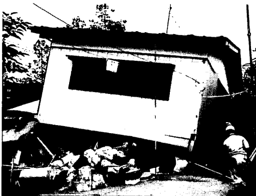
写真 9.5 被害例 3 ・ 1 階の層崩壊
