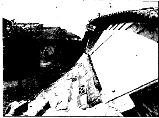
写真 9.8 被害例 4 ・東側ブロック塀の倒壊
