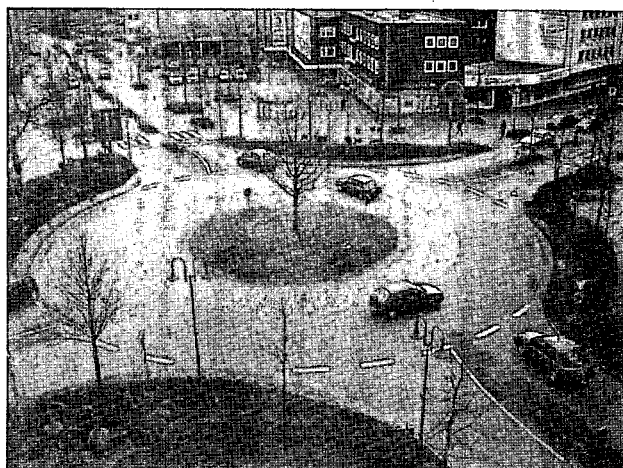
写真-1 エア・エアケンシュヴィック (独) における改築後のロータリー交差点 (州道 Landesstrasse 798 号線)
