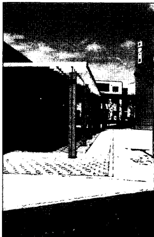
岩見沢市営日の出南団地入り口。入り口からスチールでできたしゃれた雁木が各住棟を結び、雪の季節でも移動が容易である。
