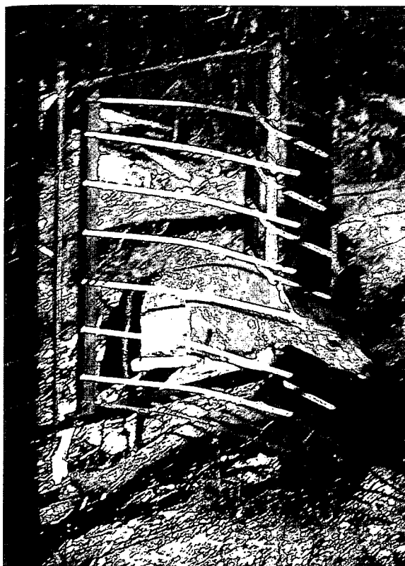
図 II-2 ワンウェイゲート (一方通行の門) をちょうどシカが通過しようとしている様子 (D. F. Reed 氏撮影・提供)
