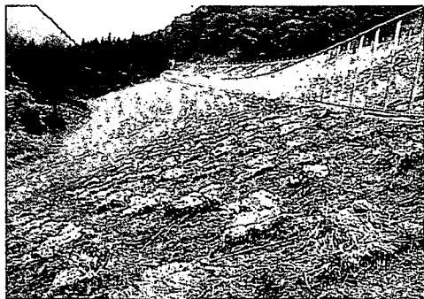
盛土に設置の動物誘導柵
