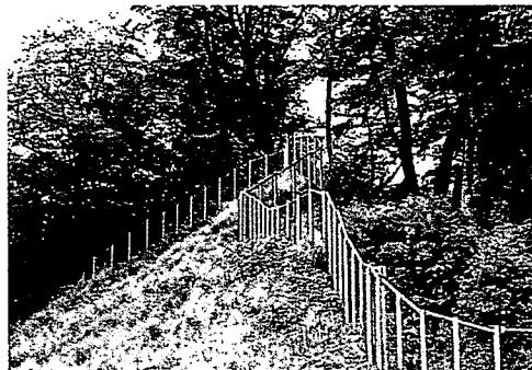
切土(最上段)に設置の動物誘導柵
