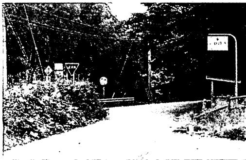
写真：市道 B 側から見た交差点の状況
