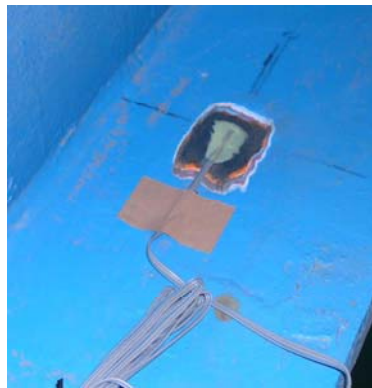
図-3.4.1 主桁下フランジのひずみゲージ設置状況
