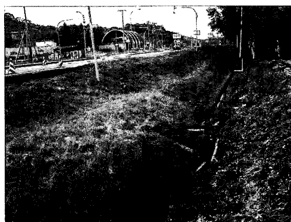
写真9.2.4 のり面のはらみ出しと側溝の移動
