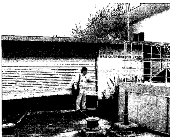
写真4.4 大津漁港奥部における痕跡
