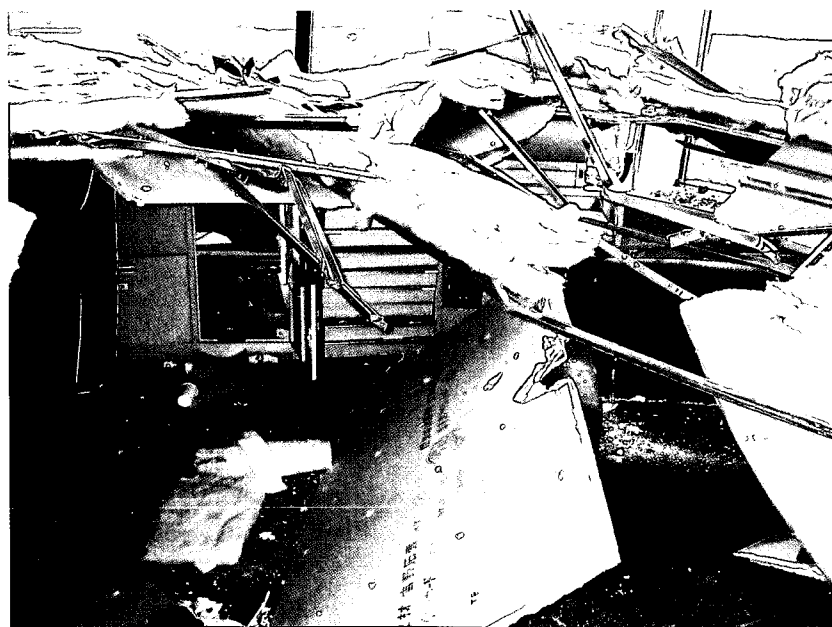
写真G 10.2 釧路空港管制塔最上階（管制室）の地震直後の状況
