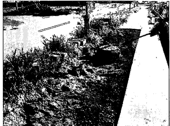
写真 6.2 鵠川町 地盤沈下の状況
