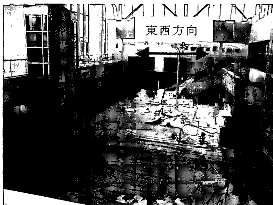
写真 10.1 落下した天井
