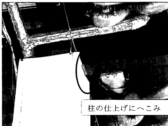
写真 10.17 東側 (柱と天井との取り合い部分)
