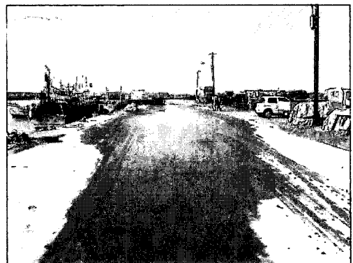
写真 4.1 浦河港の岸壁上の泥
