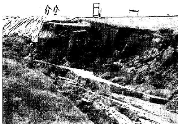
写真 7.2 堤内側法面の崩壊 (十勝川右岸 3.5k 付近)
