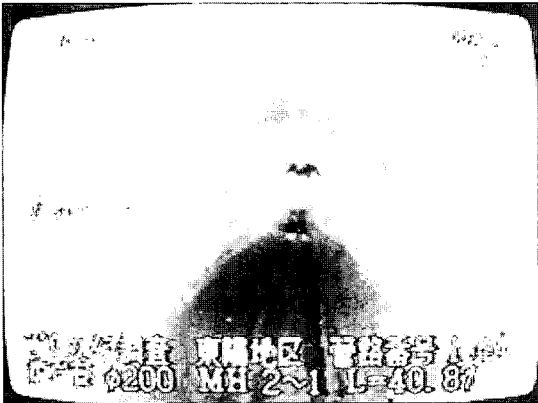
写真 6.9 釧路町 汚水管のたわみ状況 (手前側と奥の方で勾配が異なっている)
