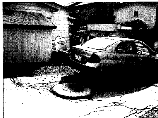
写真 10.52 マンホールの浮き上がり と道路のひび
