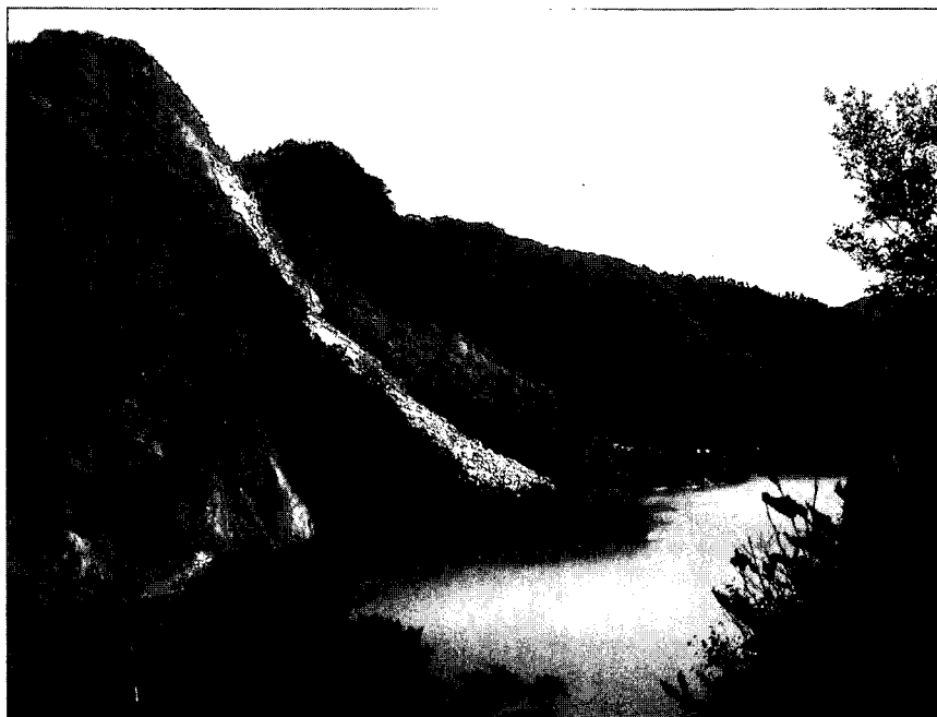
写真 9.3.13 静内ダム貯水池斜面岩盤崩壊 (道道 111 号静内ダム上流約 2km)
