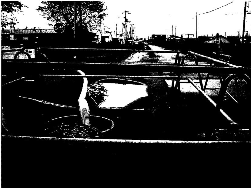
写真G 6.2 豊頃町豊頃地区の管渠の被害状況 下流の管路でマンホールの浮上がり、埋戻し部の地盤沈下が発生し、汚 水の送水ができなくなったことから、仮設ポンプとホースを用いて上流か らの汚水の対応をしている。
