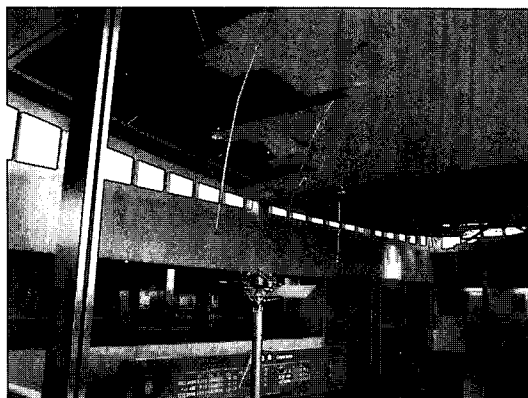
写真 10.2 地震直後の西側の天井 (調査当日の配布資料 ※3 より)
