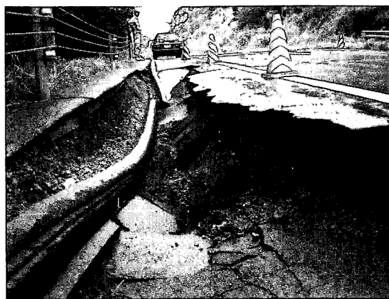
写真9.2.10 路肩の陥没
