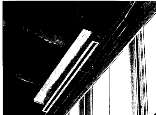
写真 10.16 東側 噴出し口付近
