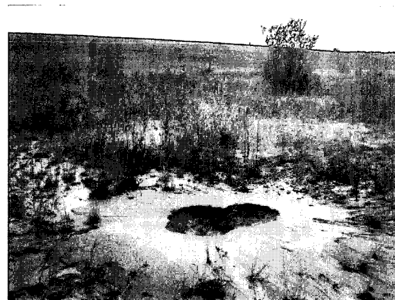
写真 7.2 堤内側法面の崩壊 (十勝川右岸 3.5k 付近)
