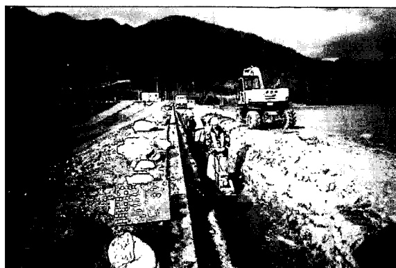
写真 8.12 クラック箇所の補修作業 (掘削状況) (高見ダム)
