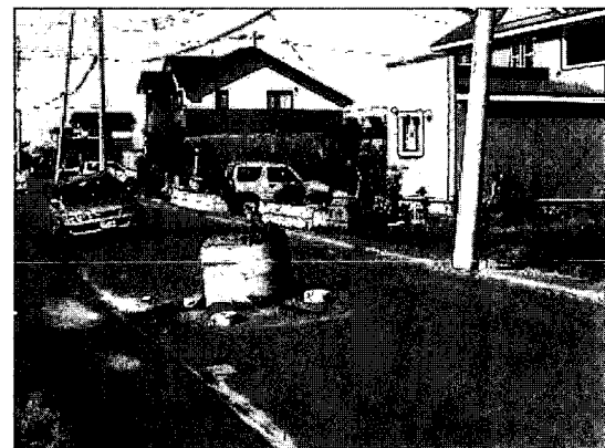
写真 6.6 釧路町 マンホール浮上がり
