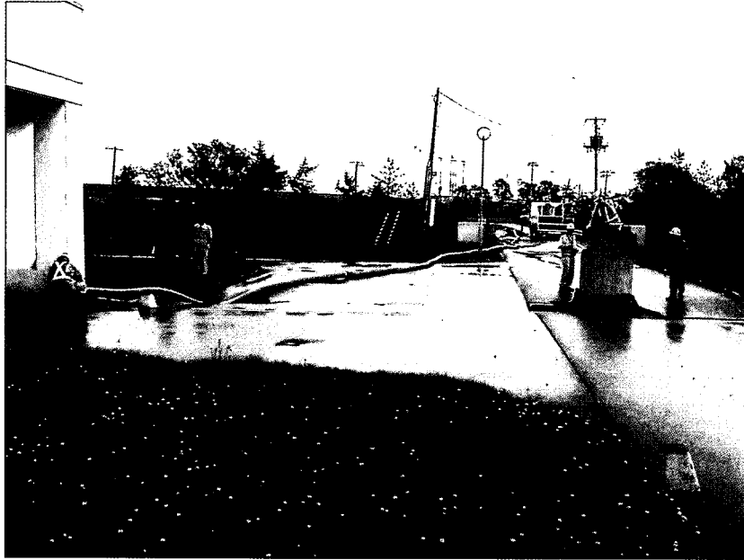
写真G 6.1 豊頃町大津下水浄化センター内のマンホールの被害状況 処理場内の流入マンホールで約1.7mの浮上がりが生じた。 処理場への汚水の流入ができなくなったことから、上流のマンホールから 仮設ポンプとホースを用いて処理場に送水している。
