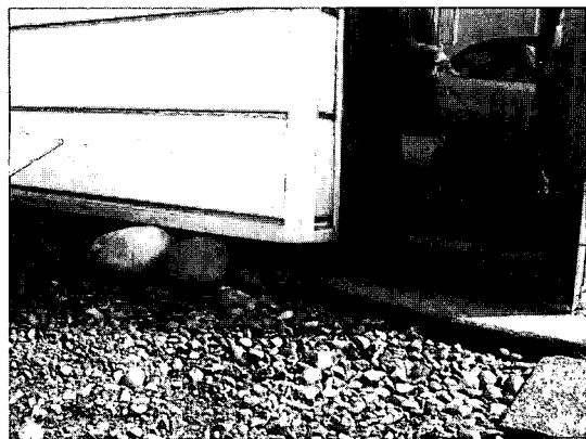
写真 10.50 玄関付近 (基礎が確認できない)
