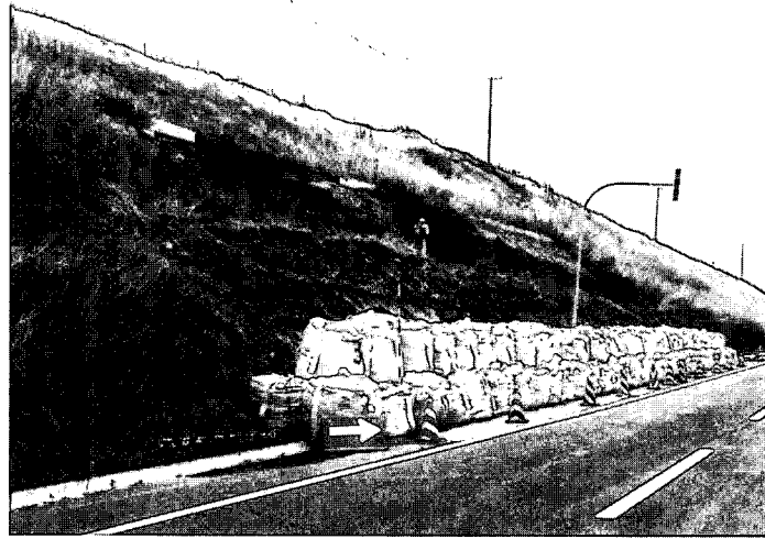
写真 9.3.6 山側切土のり面崩壊（十勝川河口側から撮影）
