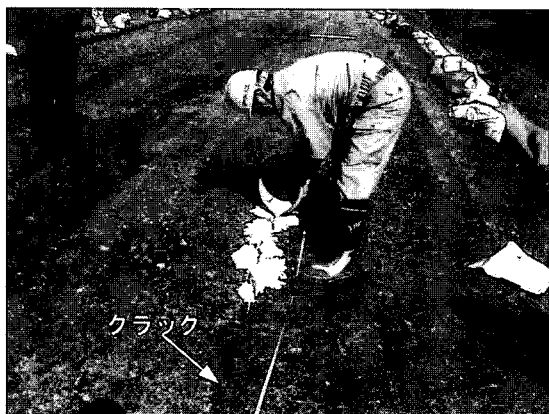
写真 8.9 クラックへの石膏の流し込み作業 (高見ダム)
