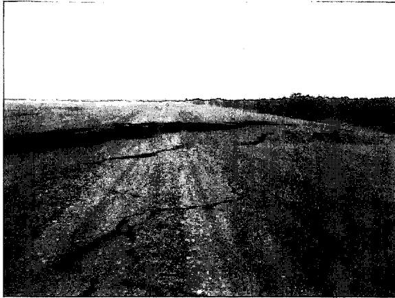
写真 7.5 天端の縦断および横断亀裂 （十勝川左岸 4.8k 付近、帯広開発建設部提供）
