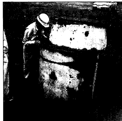
写真 6.12 豊頃町 マンホールの浮上がり (掘削深が 5m程度の区間)
