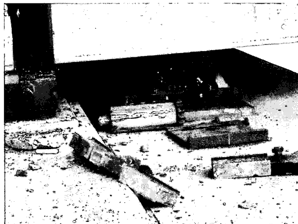
写真 9.1.5 ラーメン橋桁端部のローラー承の損傷 (ローラーの破断、逸脱)
