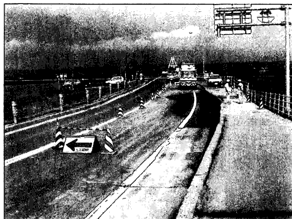
写真9.2.5 国道38号豊頃大橋の帯広側取付け部
