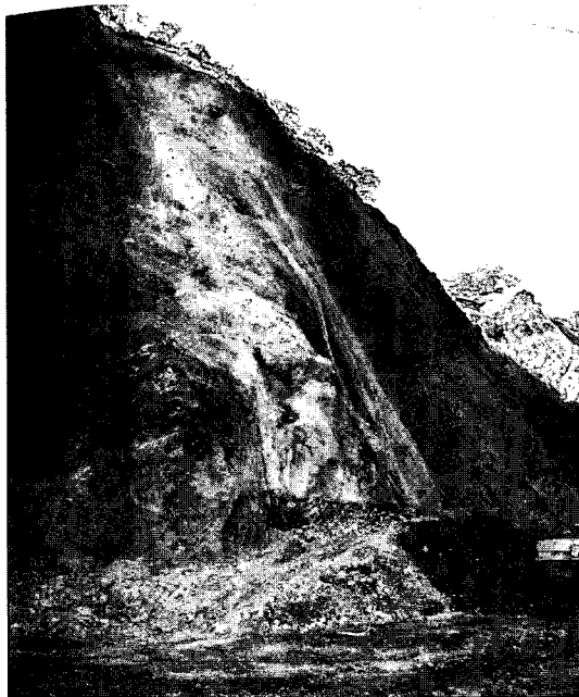
写真 9.3.4 国道 336 号広尾町（ほしば覆道）の岩盤斜面崩壊
