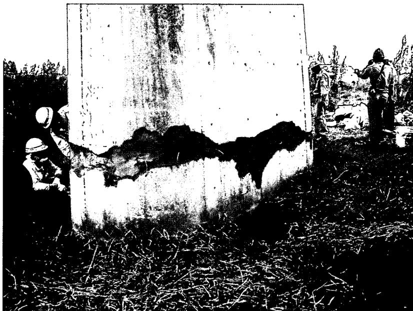
写真G 9. 1. 1 千代田大橋のRC橋脚主鉄筋段落し部の損傷 水平ひびわれ、かぶりコンクリートの剥離、軸方向鉄筋のはらみ出し かぶりコンクリートをはつり、断面修復をした状態。
