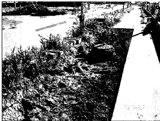
写真 6.3 鵠川町 埋戻し土の噴出状況 (植樹帯わきに火山性砂礫が噴出)
