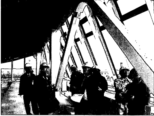
写真 10.11 東西方向には角形鋼管のブレース
