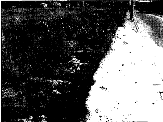
写真 6.7 釧路町 置換え砂の噴出
