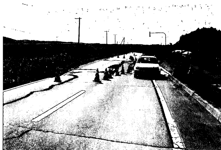
写真 9.3.12 長節一旅来間の町道の道路盛土変状 (豊頃町旅来)
