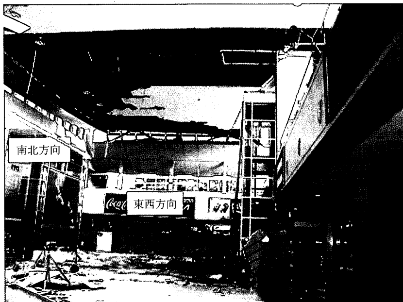
写真G 10.1 空港ターミナルビルの地震直後の状況
