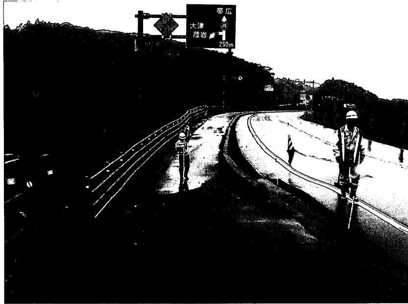
写真G 9. 2. 1 国道38号豊頃大橋の帯広側取付け部の路面の沈下(帯広開発建設部撮影)
