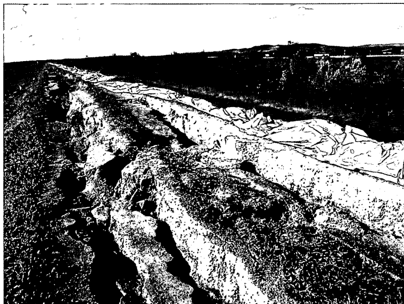
写真G 7.1 下頃辺川右岸堤防天端のクラック
