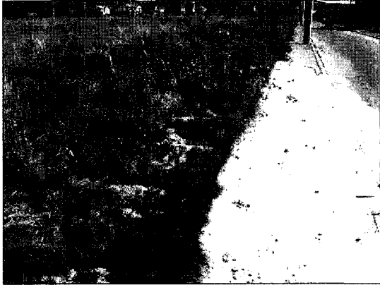
写真 6.7 釧路町 置換え砂の噴出
