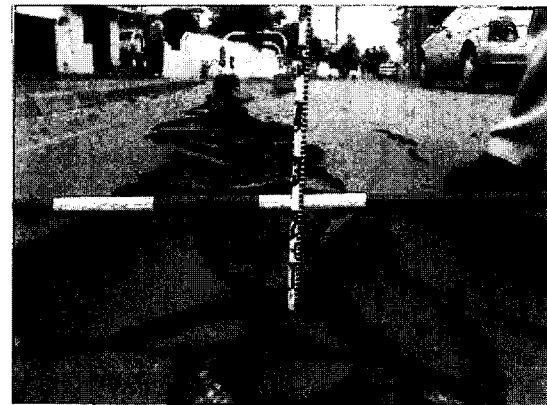
写真 6.4 釧路市 美原地区の地盤沈下
