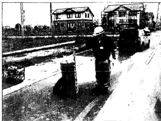
写真 6.5 釧路市 鶴野東地区の砂質土噴出 ならびに汚水マスの浮上がり
