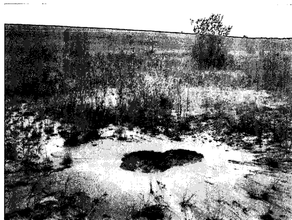
写真 7.2 堤内側法面の崩壊 (十勝川右岸 3.5k 付近)
