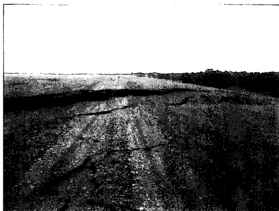
写真 7.5 天端の縦断および横断亀裂 （十勝川左岸 4.8k 付近、帯広開発建設部提供）
