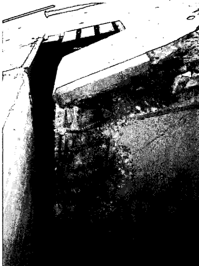
写真9.1.12 土狩大橋の桁端部の軽微な損傷（北海道開発局による）
