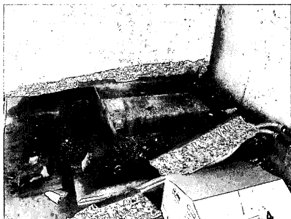
写真 9.1.4 橋台部の可動支承の損傷 (北海道開発局による)
