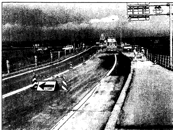
写真9.2.5 国道38号豊頃大橋の帯広側取付け部
