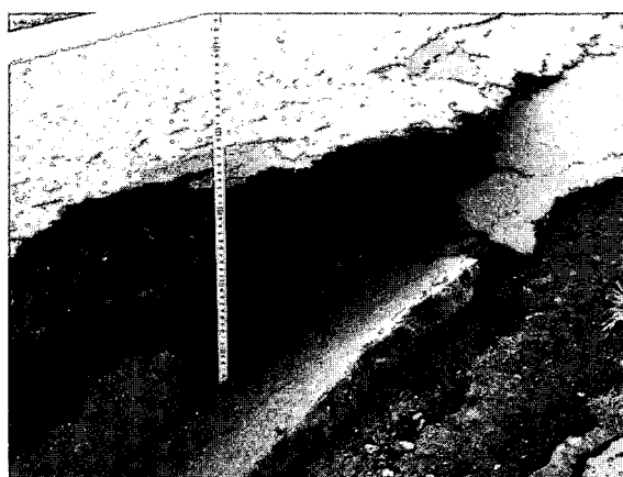
写真9.2.2 路肩の陥没
