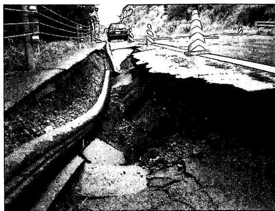
写真9.2.10 路肩の陥没
