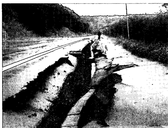
写真9.2.11 国道336号長節付近
