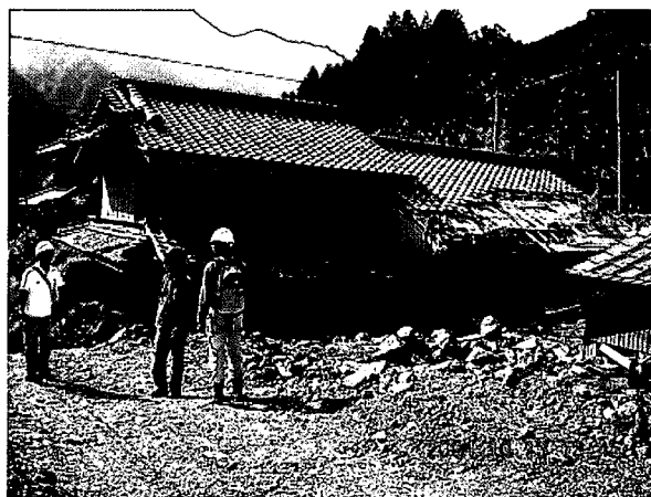
写真-4.3 三重県宮川村久豆地先土石流被災状況
