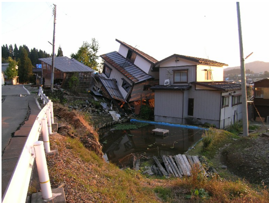
写真 G10.2 木造建築物の被害（地盤崩壊に伴う住宅倒壊）
