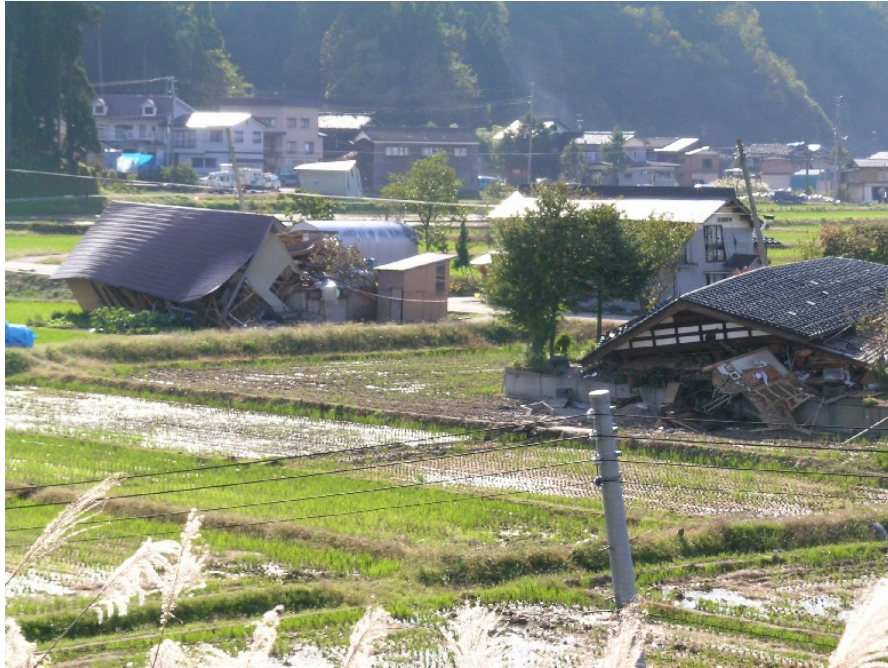
写真 G10.1 木造建築物の被害（住宅倒壊）
