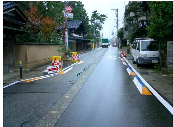
写真-1 双方向通行道路における狭さくの設置
