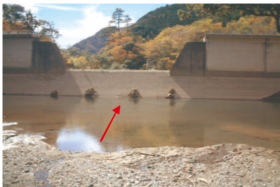
平成 13 年度 4 月撮影 堆砂状況
