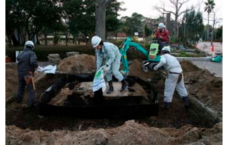
写真6 植樹枿の拡大(土壤改良)
