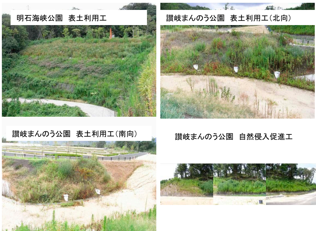
写真-1 明石海峡公園と讃岐まんのう公園の平成19年9月における法面の植生状況
