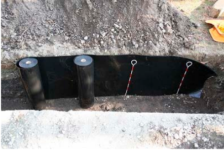
写真4 根系遮断シート
