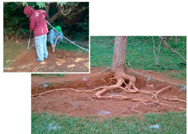
写真1 圧縮空気を利用した土壌掘削
