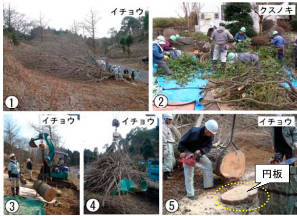
写真1 地上部の伐倒作業
