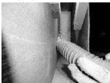
図 11 壁体内へ EPS を吹き込む様子
