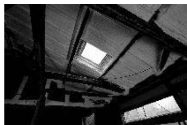
図10 天井を撤去して工事を行えば、新築の場合と同等の施工状況となり安全
