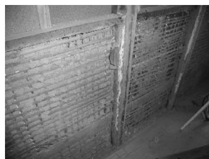
既存の壁を解体した際に現われた土壁
