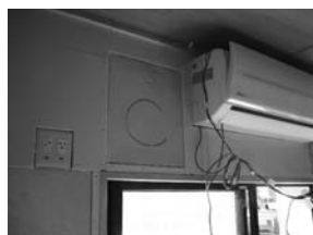
図 13 壁面の改修状況
