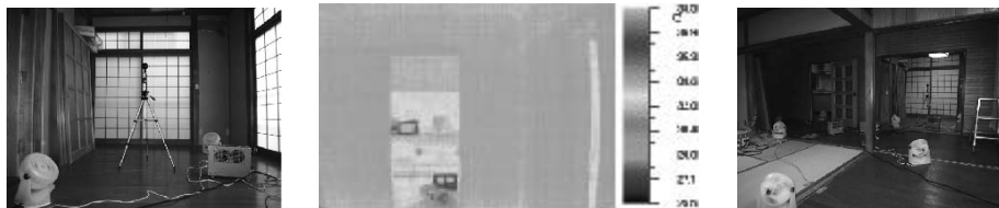
写真 2 1階廊下間仕切壁表面温度分布(改修前:室内 20.3^\circ\text{C} 、外気 7.8^\circ\text{C} 、改修後:室内 32.3^\circ\text{C} 、外気 9.3^\circ\text{C} )
