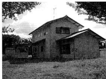
戸建て住宅外観
