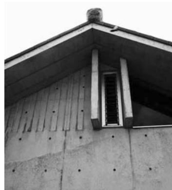
図 11 妻壁の高窓に設けた袖壁
