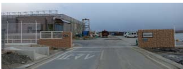
写真-3 復旧工事中の久慈国家石油備蓄基地 (2012.1.31筆者撮影)
