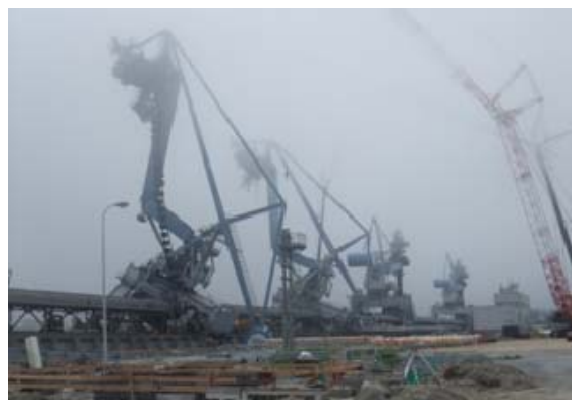
写真-12 被災した相馬共同火力発電所専用岸壁のアンローダー（2011.7.7筆者撮影）
