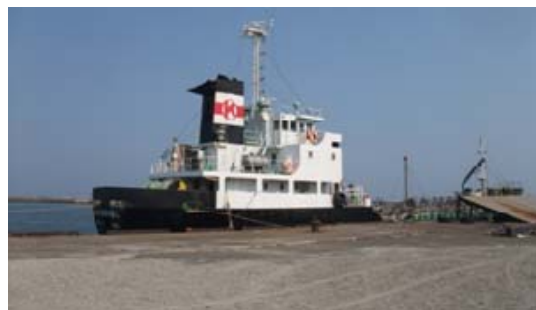
写真-14 仮復旧した岸壁でガソリン陸揚中のタンカー (2011.3.30筆者撮影)
