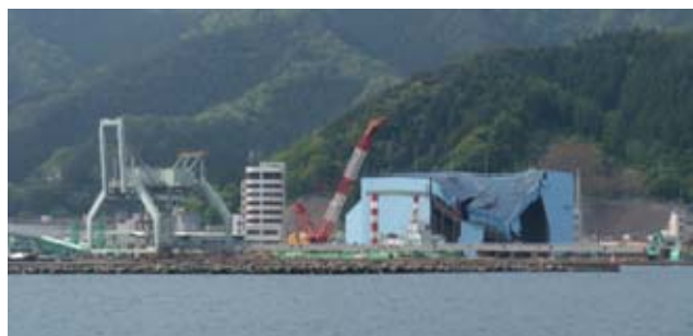
写真-5 被災した新日本製鉄の専用棧橋（青い建屋が全天候バース。船舶の衝突を受け大きく破損した。左のアンローダーは石炭・飼料の荷揚げ用。2011.5.19筆者撮影）
