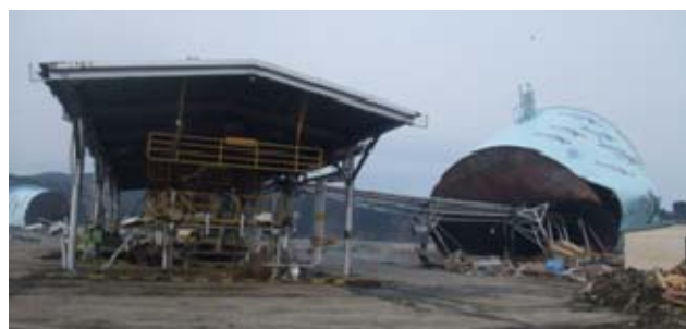
写真-7 被災した気仙沼港の油槽所（2011.4.26筆者撮影）
