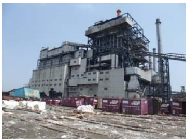
写真-10 被災した日本製紙石巻工場。工場の1階部分の壁が破壊されている。また、写真手前のJR貨物石巻港駅には鉄道コンテナや中身のロール紙が散乱している。
