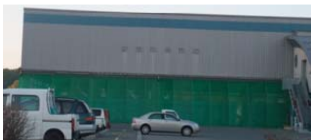
写真-4 仮復旧した宮古魚市場（2011.5.18筆者撮影）
