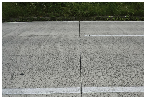
写真 2.1 健全な目地材の例
