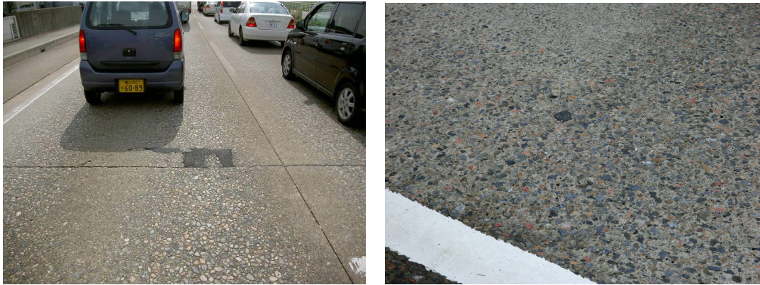
写真 2.12 路面部のポリッシングの例
