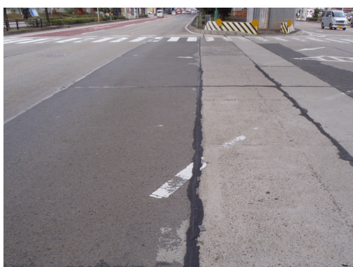
写真 2.2 目地材のはみ出しの例 1)
