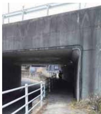
写真-5.7.2 ボックス内の歩道
