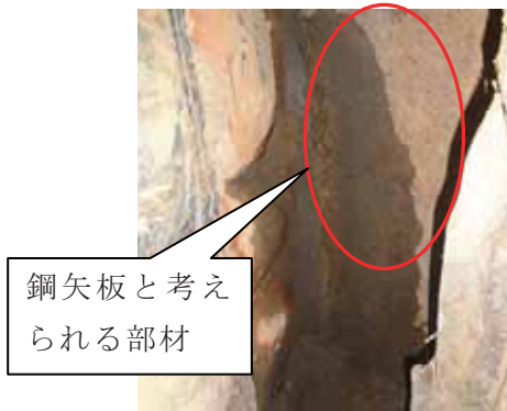
(c) 目開き部背面の土の流出防止対策
