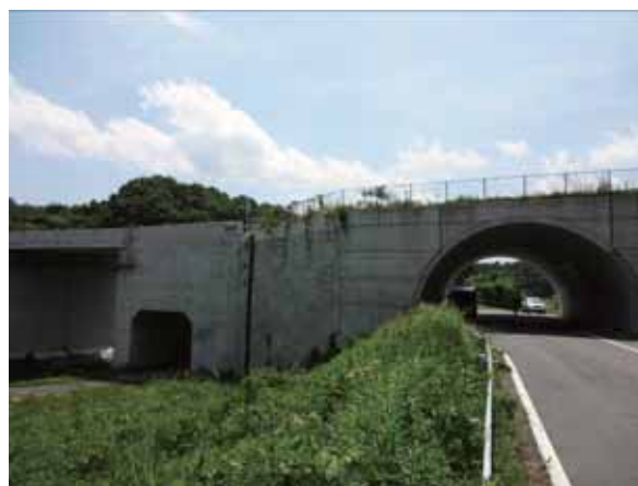
写真-5.6.2 アーチカルバート全景 (東側)
