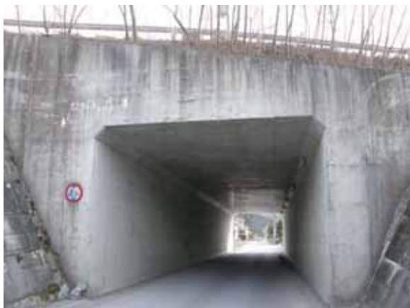
写真-5.4.1 ボックスカルバート全景
