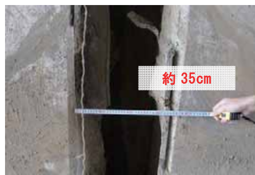
(c) 継手部の拡大
