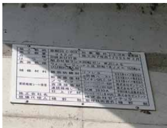
写真-5.1.4 上床版の補修履歴
