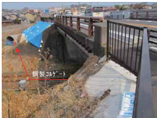
写真-5.11.1 東側盛土部と鋼製コルゲート(新富士見橋西側より)
