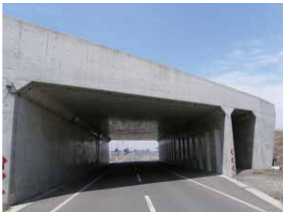
写真-5.3.1 ボックスカルバート全景
