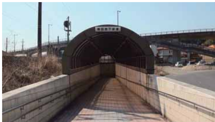
写真-5.8.1 植田地下歩道スロープ部の入口(奥が植田跨線橋)
