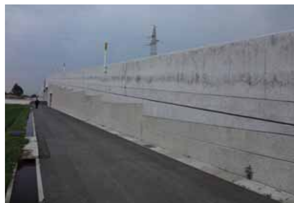
写真-5.9.3 補強土壁の状況
