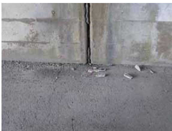
写真-5.1.3 目地部の開き及び コンクリート片の落下
