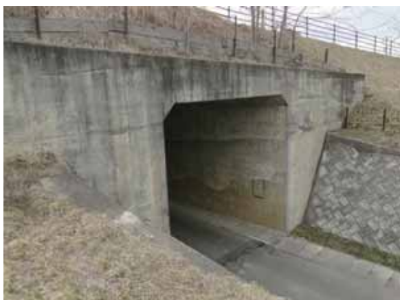
写真-5.5.1 ボックスカルバート全景
