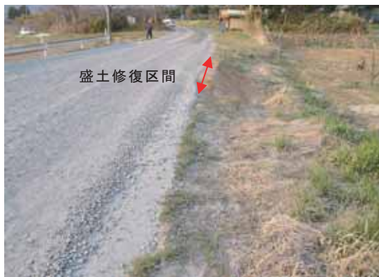
写真-5.13.3 盛土箇所の修復状況
