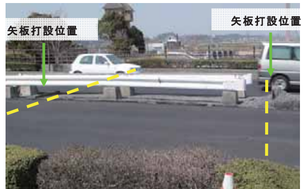
(d) 道路面での矢板設置状況
