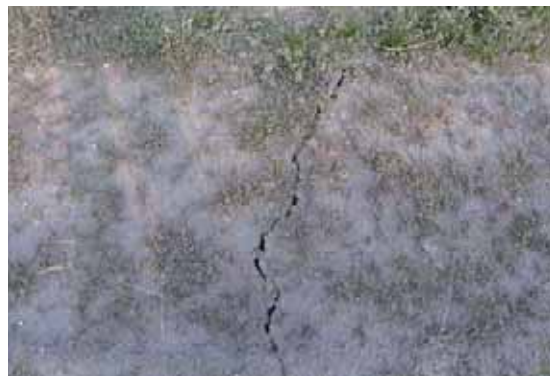
写真-5.13.5 盛土周辺の地盤のひび割れ
