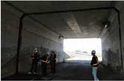
(a) ボックスカルバート内部の状況
