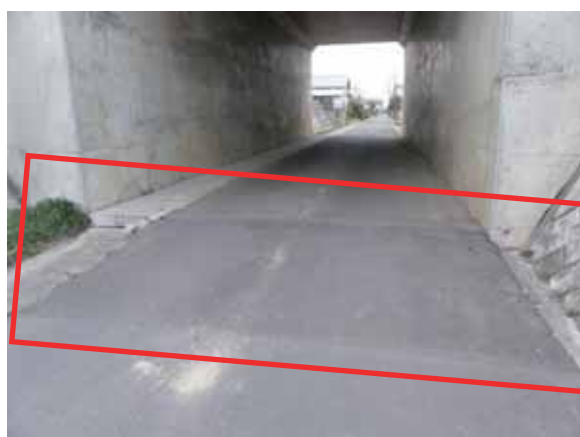
写真-5.5.4 カルバート境界部での段差補修跡
