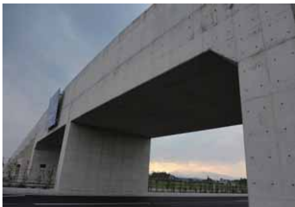
写真-5.9.2 2連ボックスカルバートの状況
