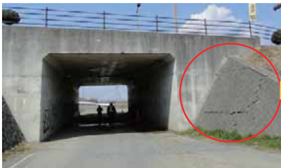
(a) ボックスカルバート側面の擁壁部
