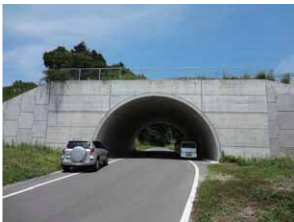
写真-5.6.1 アーチカルバート全景 (西側)
