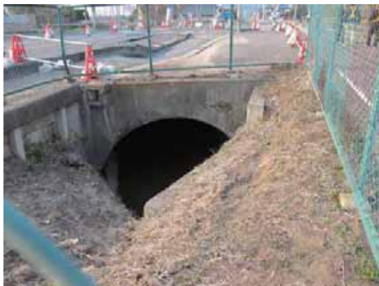
写真-5.12.1 茨城県道 14 号の鋼製コルゲート
