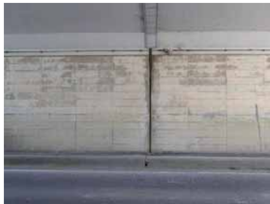
写真-5.1.2 上下線の目地部
