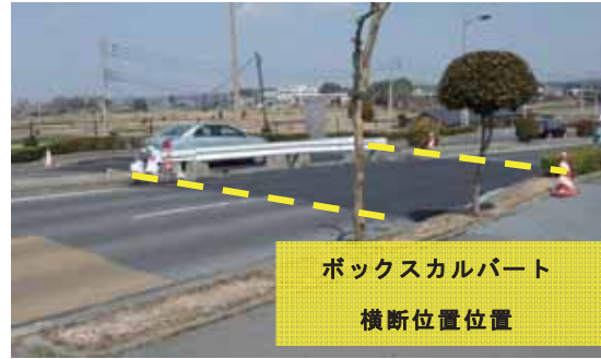
(b) ボックスカルバート直上部の補修状況
