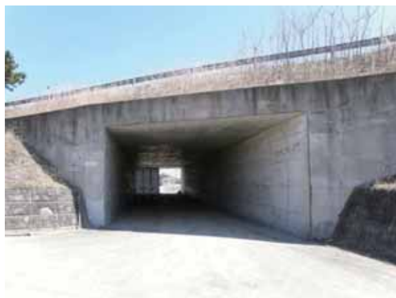
写真-5.2.2 幅約 5.5m のボックスカルバート(山側より)
