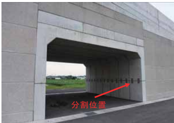
写真-5.9.4 プレキャスト製1連ボックスカルバートの状況
