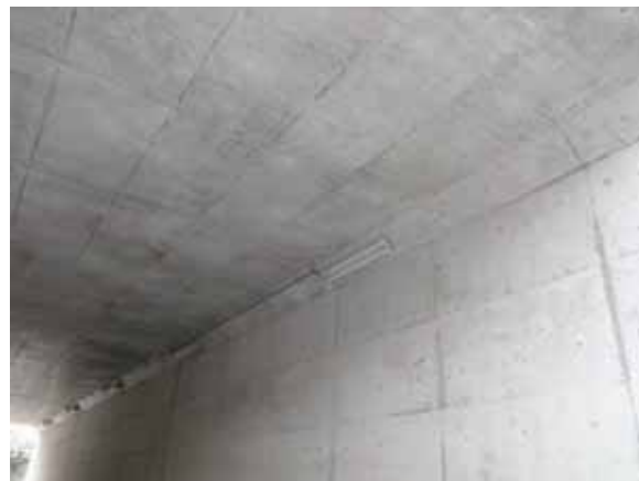
写真-5.4.2 ボックスカルバート内部の 状況
