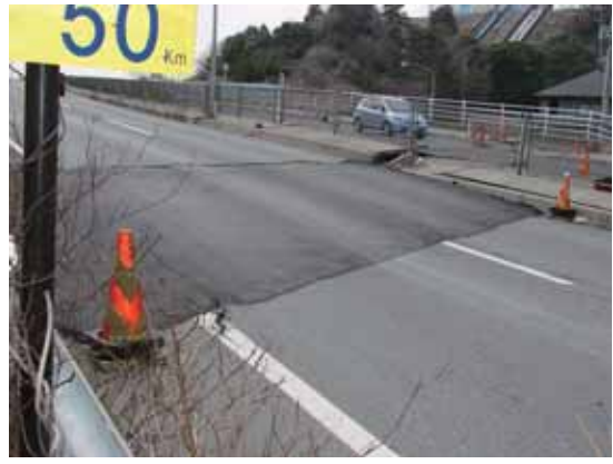
写真-5.7.6 常磐バイパスの段差補修状況
