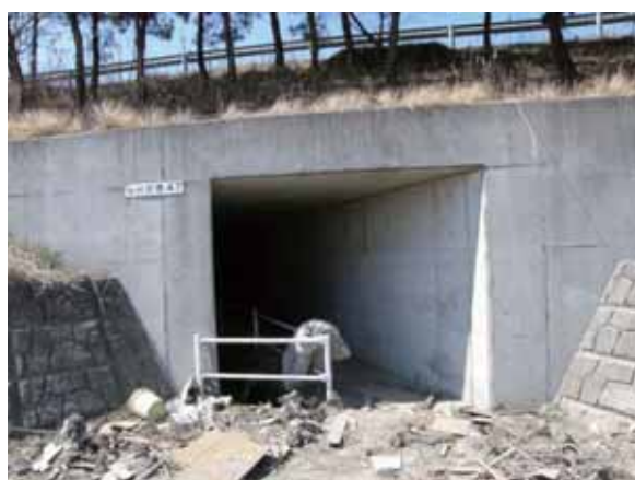
写真-5.2.3 幅約 2.5m のボックスカルバート(海側より)
