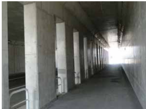
写真-5.3.2 ボックスカルバート内歩道部の状況
