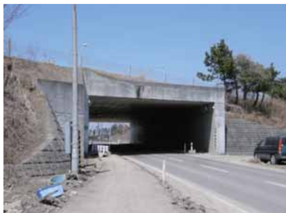
写真-5.2.1 幅約 12m のボックスカルバート(海側より)
