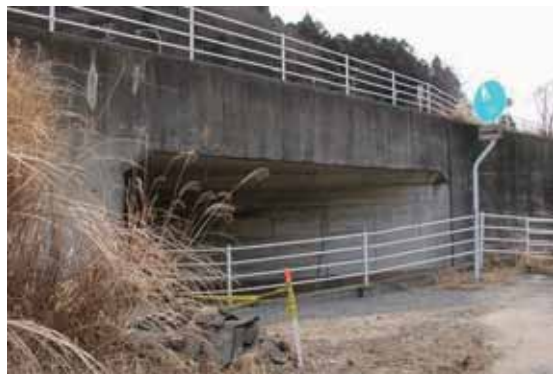
写真-5.7.1 南富岡アンダーボックス全景
