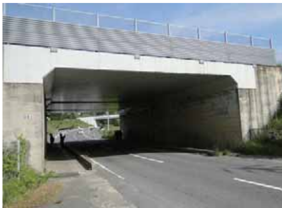
写真-5.1.1 ボックスカルバート全景
